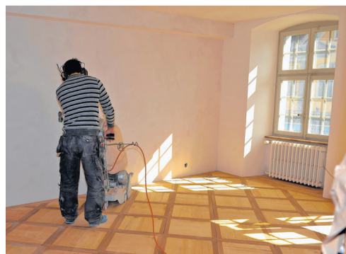
Zimmer: Der Kassettenboden aus dem Depot wird geschliffen.
