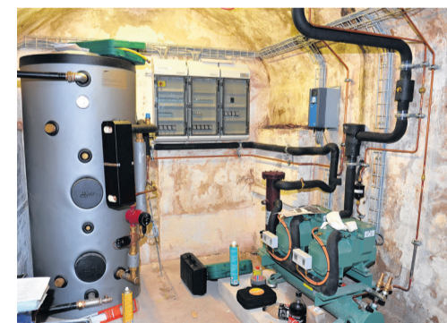
Die Wärme aus den Kühlgeräten wird für Warmwasseraufbereitung verwendet.
