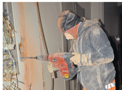
Budi Herzig im Einsatz: Durchbruch zur Küche musste erstellt werden.
